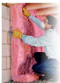
③断熱材写真(1)
