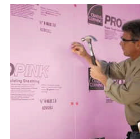
⑤断熱材写真(3)
