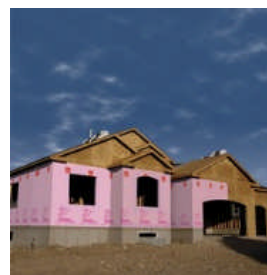
④断熱材写真(2)
